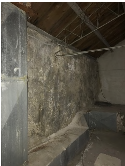
Particolare interno copertura a volta e a falde con evidenti infiltrazioni di acque meteoriche
