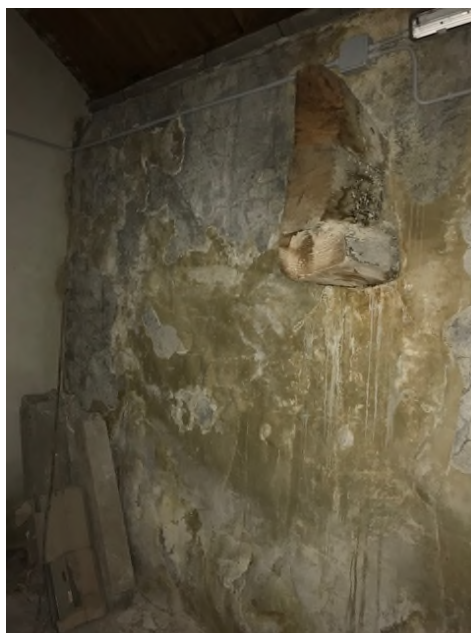
Particolare interno copertura a volta e a falde con evidenti infiltrazioni di acque meteoriche
